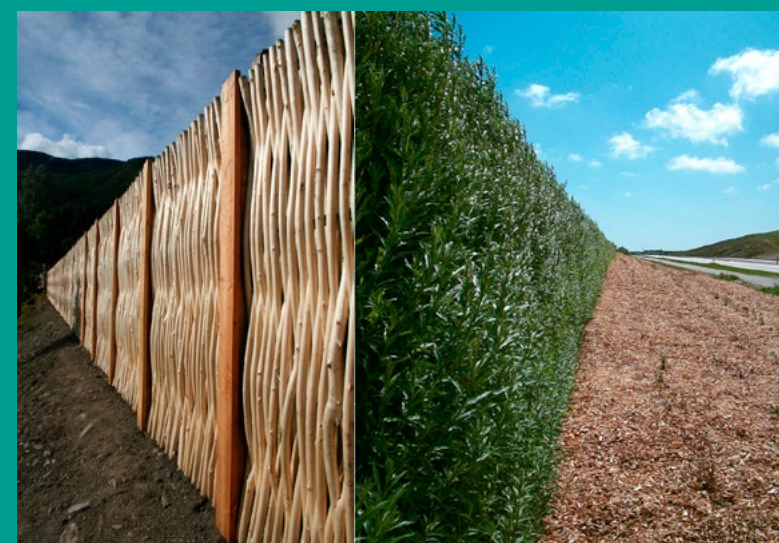
Skärm i torkad pil och i utväxt form. Bild: Byggros
