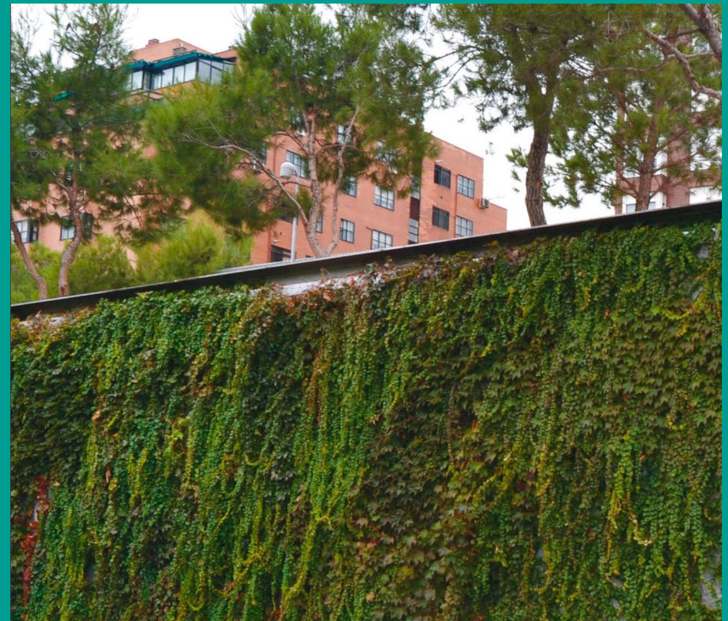
Skärmen syftar till att dämpa buller och partikelspridning från väg.
