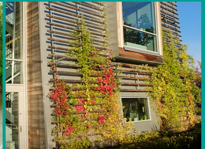
Skärm i torkad pil och i utväxt form. Bild: Byggros
