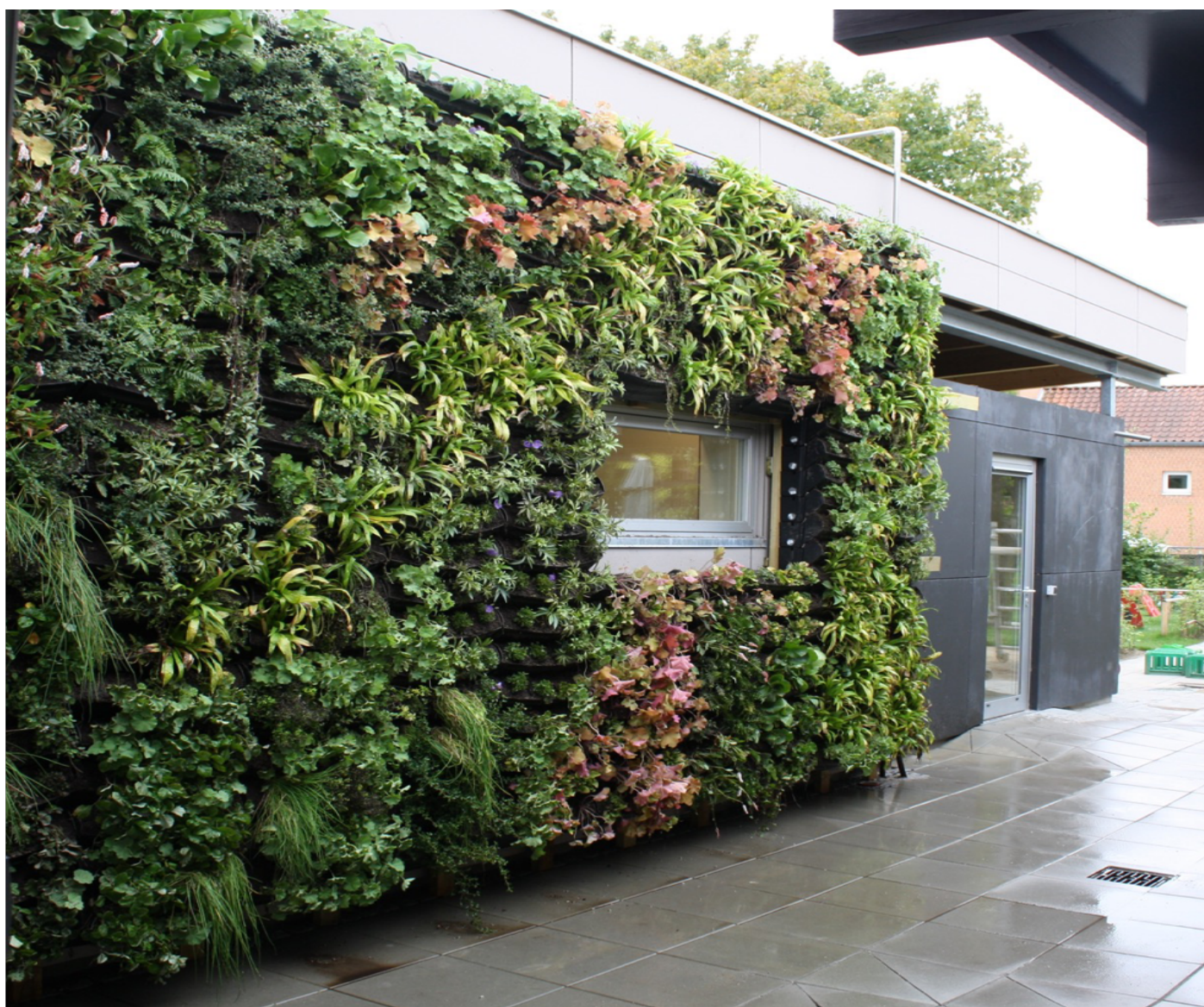
Foto: Levande vägg på Takträdgården i Augustenborg, Malmö. Den nedre bilden är från en anläggning i Odense med samma system. Byggros 2022.
