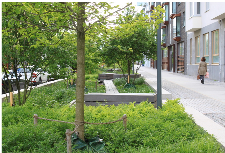
Figur 6. Genom att anlägga regnbäddar i kombination med plantering av träd och örter, kan dagvatten filtreras och renas med hjälp av vegetationen. Här är ett exempel på ett grönt gaturum i Norra Djurgårdsstaden. Foto: Stockholms stad.
