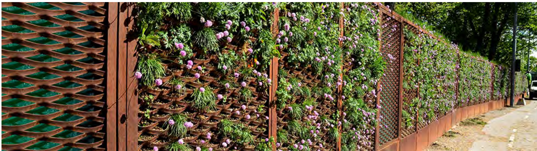
Figur 11. Anläggning av växtväggar, även kallade "gröna väggar", kan med rätt utformning och växtval gynna pollinatörer och förslagsvis anläggas dessa integrerat som bullerdämning intill vägar. Exempel från Lidingövägen. Foto: Johan Pontén.
