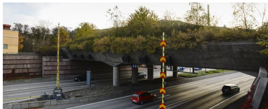
Figur 14. Genom att skapa ekodukter över vägar och järnvägsspår med mycket trafik gynnas en mängd olika arter. Åtgärden bedöms även som mångfunktionell då den gynnar friluftslivet med förbättrad rörlighet och minskad barriäreffekt.
