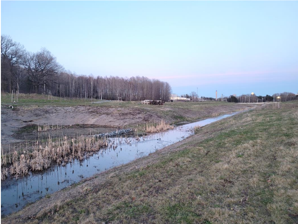
Figur 2. Stordikets delsträcka 5+7 med intilliggande damm nr 6, anlagd övervintringsplats för groddjur i närheten av upplagda stockar i bakgrunden. Vegetationen i Stordiket och dammarna har ökat ytterligare sedan föregående inventering 2023. Detsamma gäller vegetationen vid sidan av vattnet som nu har etablera sig bra och rötterna hjälper till att hålla leran på plats. Bild: Mandus Wester 2024
