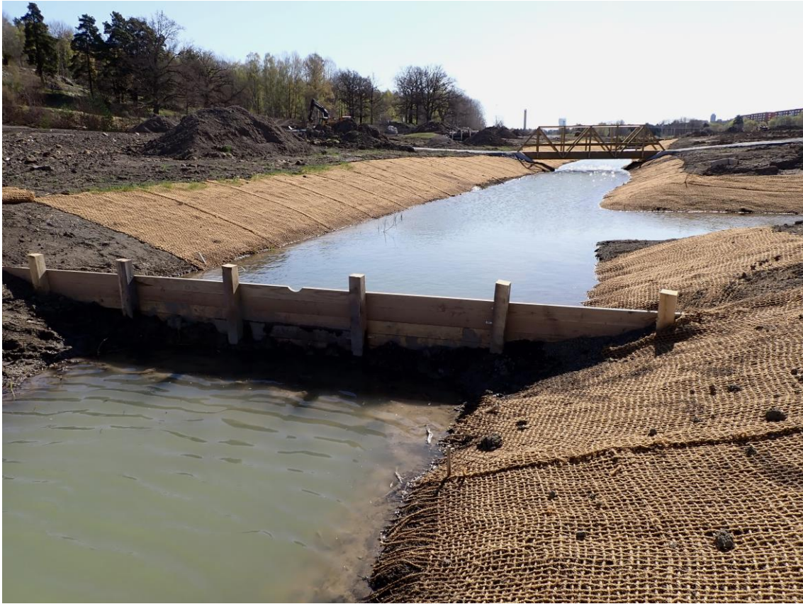
Figur 2. Områdets nya utseende efter omarbetning som pågick under perioden 1 oktober 2021 till 31 mars 2022. Närmast i bild ser vi ett dämme och längre bort en av de nya broarna. Till höger i bild ser vi inloppet till en av de nya salamanderdammarna (lokal 3) som ligger i anslutning till diket.
