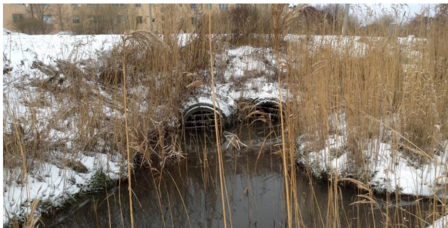
Kulvert under Spångavägen. Foto: Ekologigruppen
