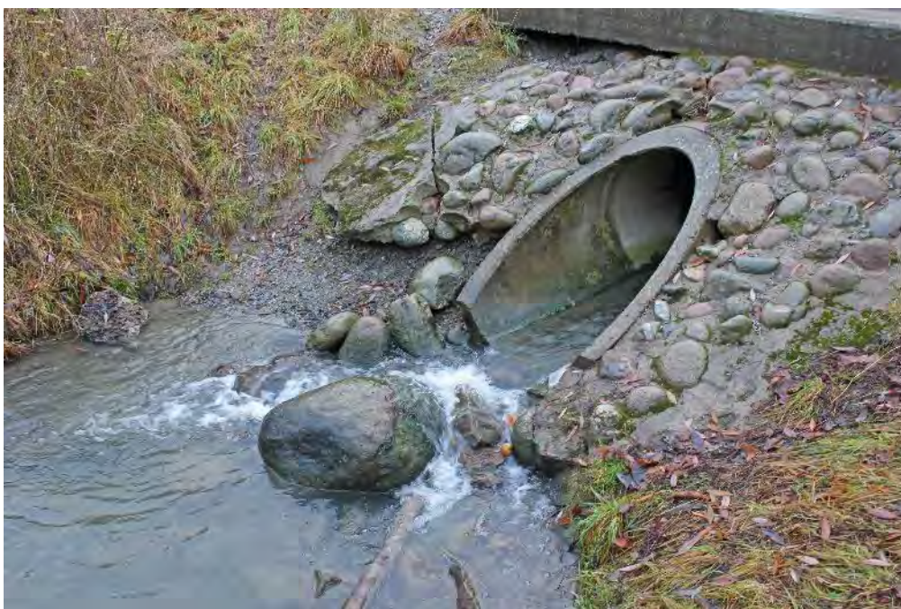
Figur 30. Vandringshinder VH5:3 består av en sluttande kulvert under en bro
