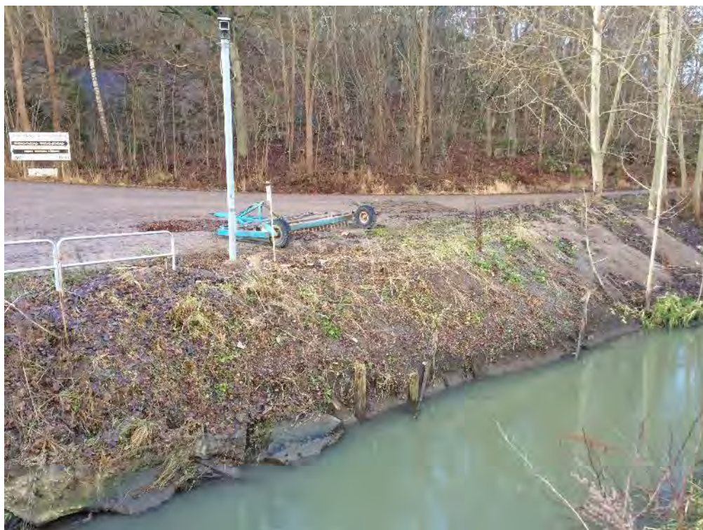
Figur 14. Där vägladdarna till träningsstravbanan parkeras kan material sköljas ned i ån
