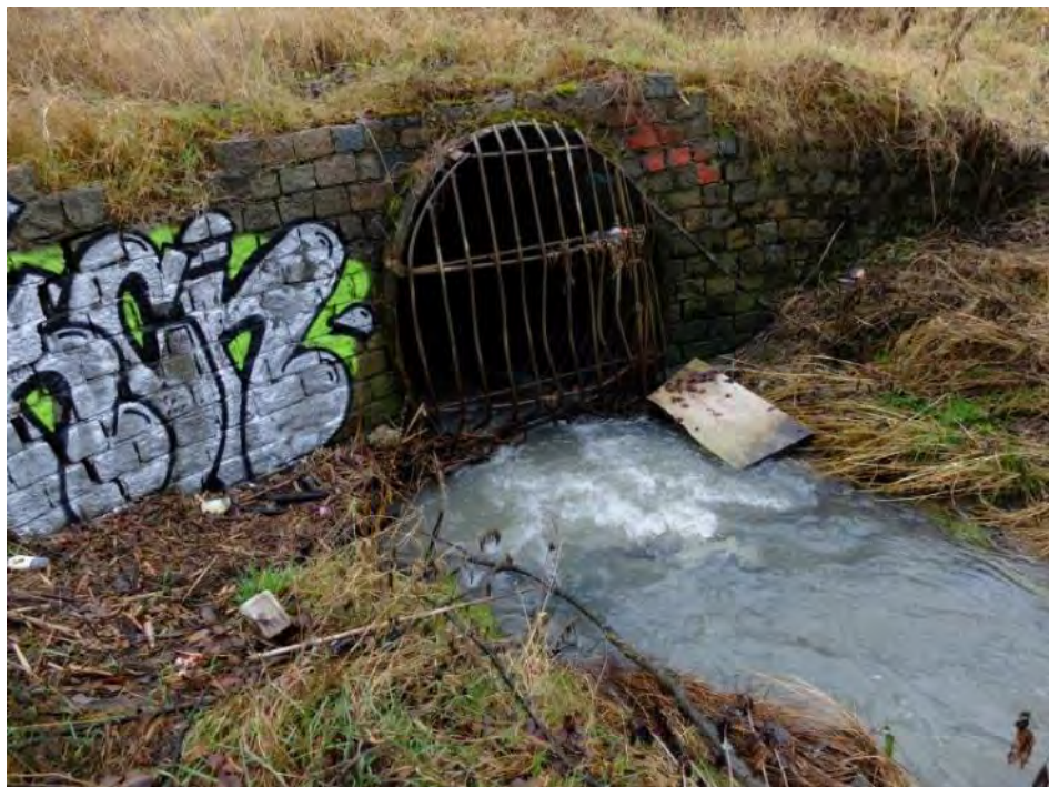
Figur 22. Vid vandringshinder VH3:4 begränsas konnektiviteten också av snabbt strömmande vatten. Foto: Emåförbundet
