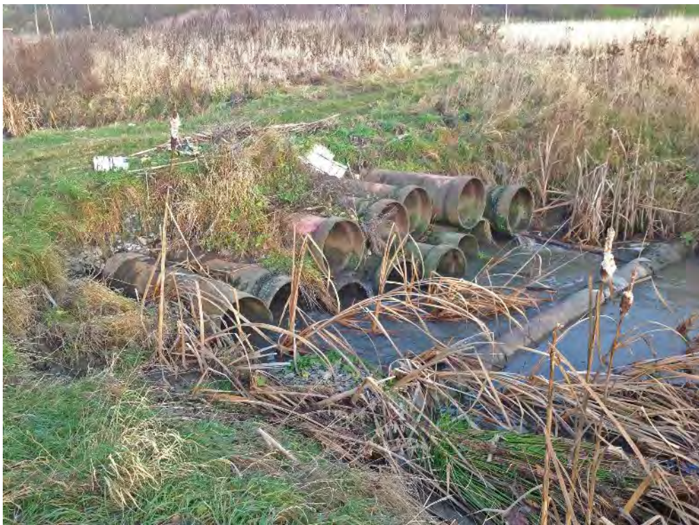
Figur 25. En större mängd små trummor utgör vandringshinder VH4:1
