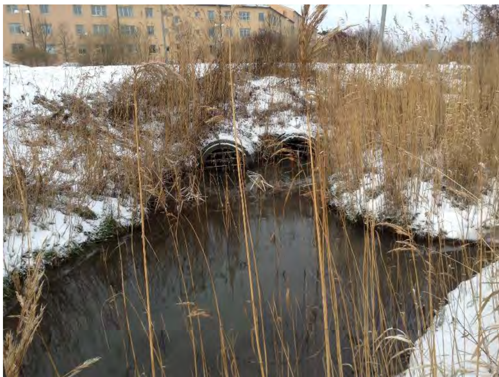
Figur 35. Vandringshinder VH 6:1 utgörs av ett galler där skräp kan fastna. Vid vandringshinder begränsas konnektiviteten också av snabbt strömmande vatten.
