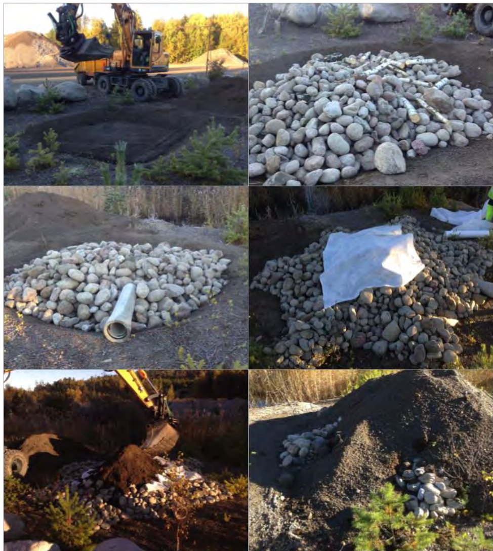
Figur 54. Anläggning av en övervintringshög för groddjur.
