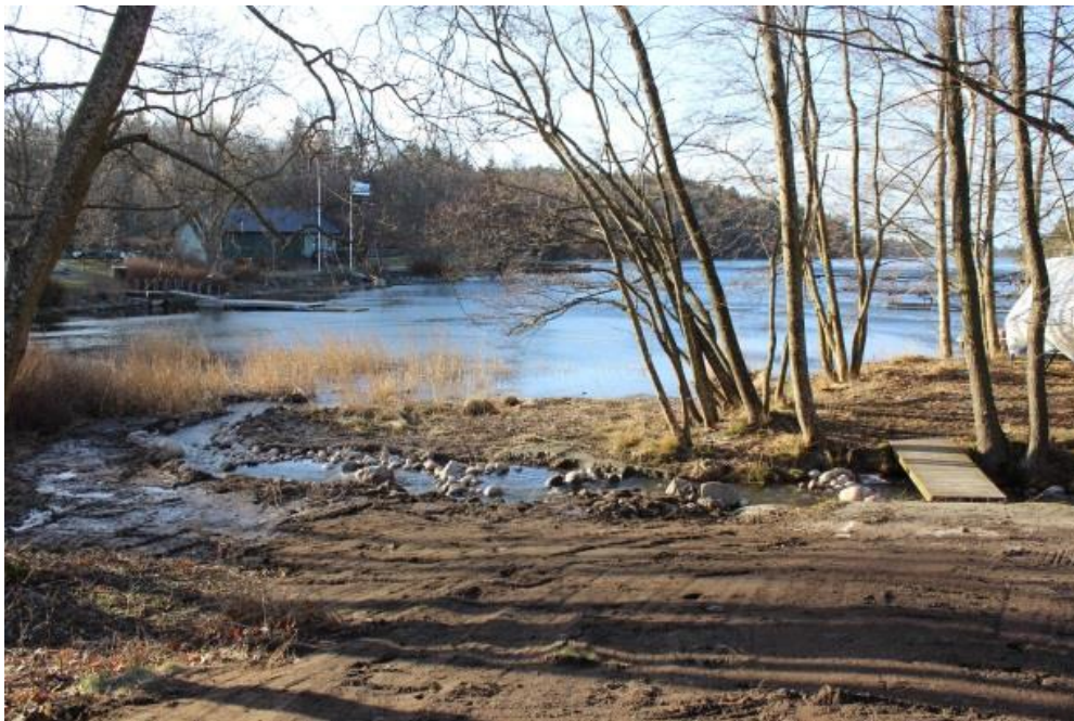
Figur 10: Restaurerad och återmeandrad bäckfåra vid Insjöbäcken, Nacka. Målarten för projektet var att skapa fria vandringsvägar för gädda, abborre och andra sötvattensfiskar mellan Östersjön och Insjön.
