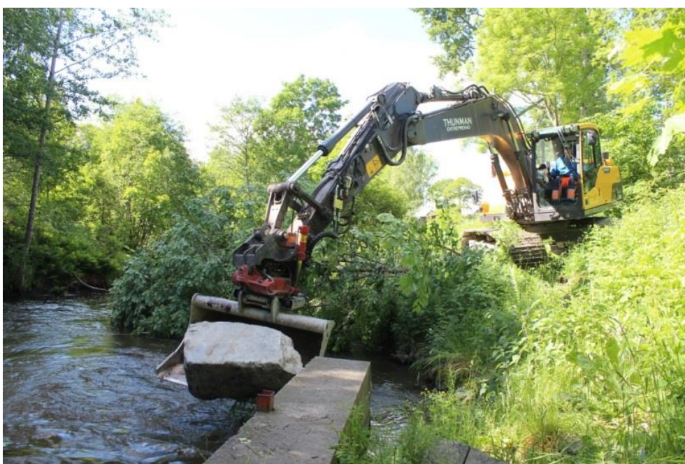
Figur 8. Att återföra grus och stenmaterial är viktigt i rätade och rensade vattendrag. Grunda grus och stenbottnar med strömmande vatten är vattendragens mest artrika miljö. Många fiskarter är knutna till denna typ av miljö under någon gång i sin livscykel. Foto: Rickard Gustafsson.
