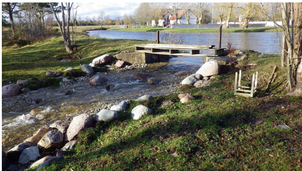
Figur 12: Bilden visar en restaurerad  str cka som tr sklats. Tidigare hindrande en damm fiskvandring. Vandringshindret togs bort och str mstr ckan nedstr ms tr sklades f r att bibeh lla vattenniv  i vattenspegeln uppstr ms.
