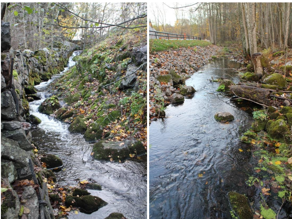
Figur 19. Lokalt i framför allt Follbrinksströmmen är vattendraget kraftigt fysiskt påverkat genom rensning och kanalisering på grund av en väg som går alldeles intill åfåran och långa stenmurar. Källa Norconsult 2016.
