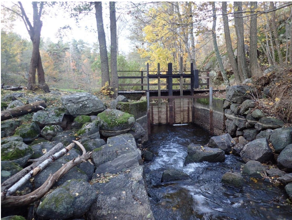
Figur 24. Kvarndammen har ett utskov inrett med två spettluckor. Norconsult 2016.
