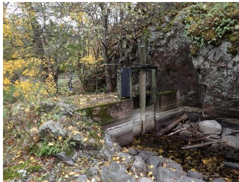
Figur 16. Krondammen vid Nyfors. Norconsult 2016.
