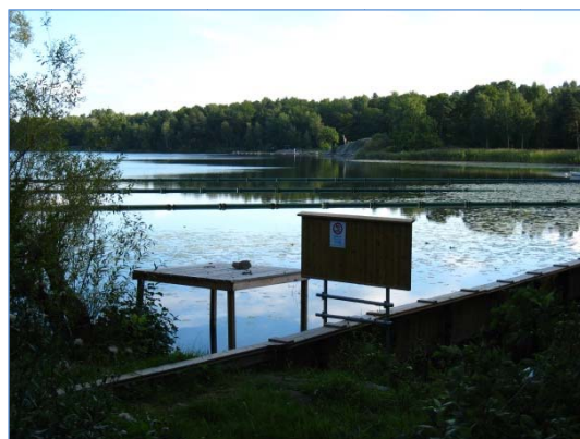
Vid Drevvikens nordvästra ände har en skärmbassäng anlagts som renar dagvatten. Foto: Magnus Sannebro.
