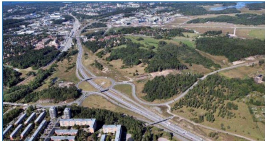
Figur 9. Vy över E18 med området mellan Hjulsta och Barkarby (Källa: Trafikverket)
