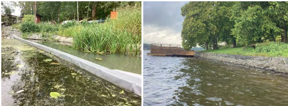
Figur 33. Naturvärdesbiotoperna S11 - skärmbassäng för näringsretention (vänster) och G10 (höger) har visst naturvärde och utgörs av antropogen limnisk miljö med anläggningar i vattnet eller anlagd strand där förekomst av ovanliga och skyddsvärda arter saknas helt eller är få.
