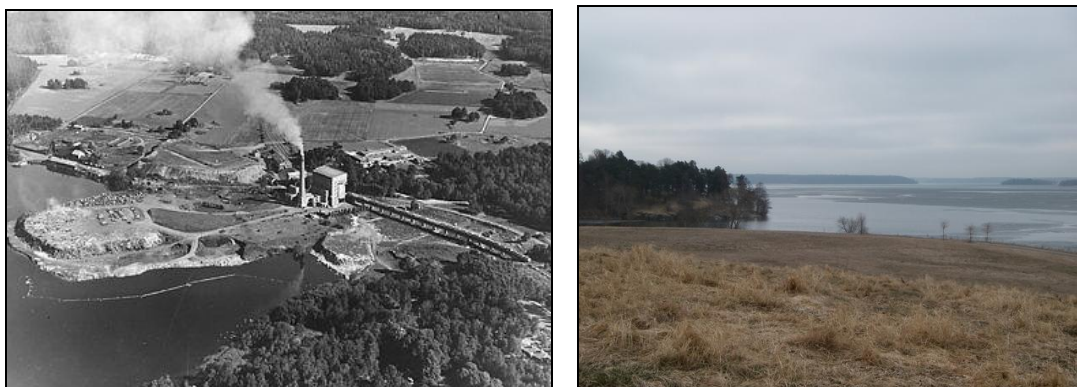
Fig. 7 och 8. T.v. Lövsta sopförbränningsanläggning vid Lövstafjärden 1959. Foto: Oscar Bladh (fr. Wikipedia). T.h. Utsikt från Lövsta gamla deponiområde som efterbehandlats och sluttäckts med jord samt gräsbesått enligt deponiförordningen (2001:512) och därigenom omvandlats till parkmark. Foto: anonymus.
