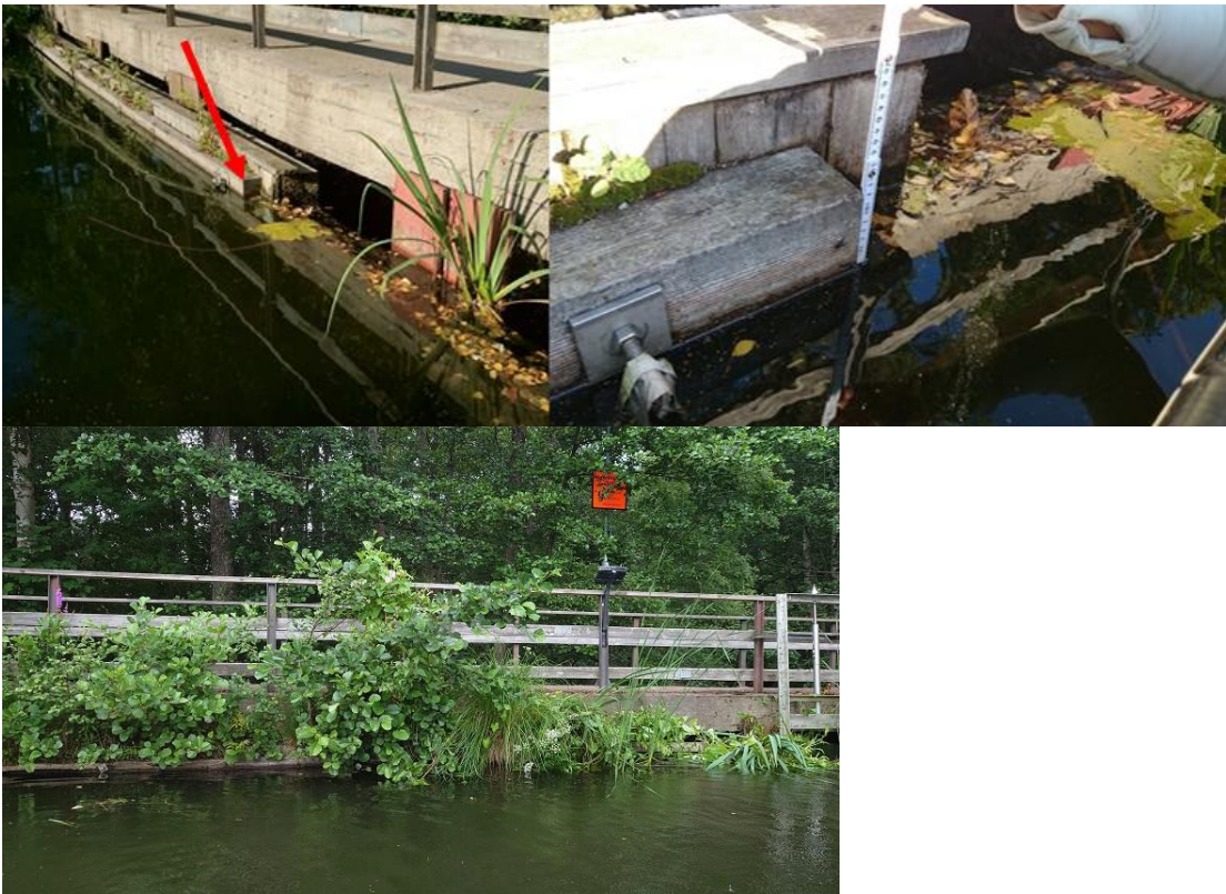
Långsjön: Vattenståndet mättes in mot balk vid damm vid utloppet. De övre bilderna är från inventeringen 2014. Vid årets inventering var området igenväxt av sly och annan vegetation (nedre bilden).
