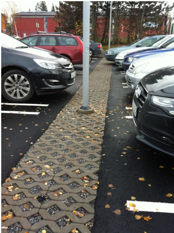
Figur 6. Parkeringar kan LOD:as med betonghålsten.
