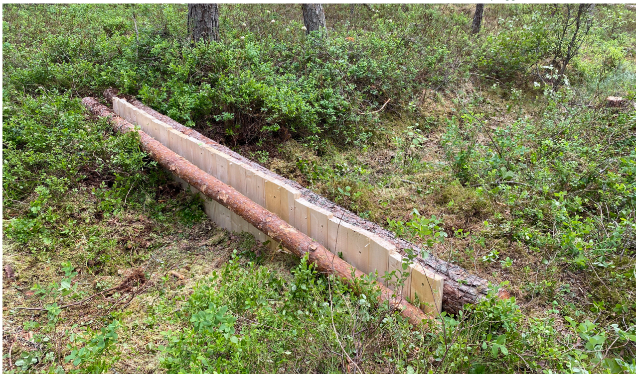
Palissadplugg i dike. Foto, Sören Eriksson
